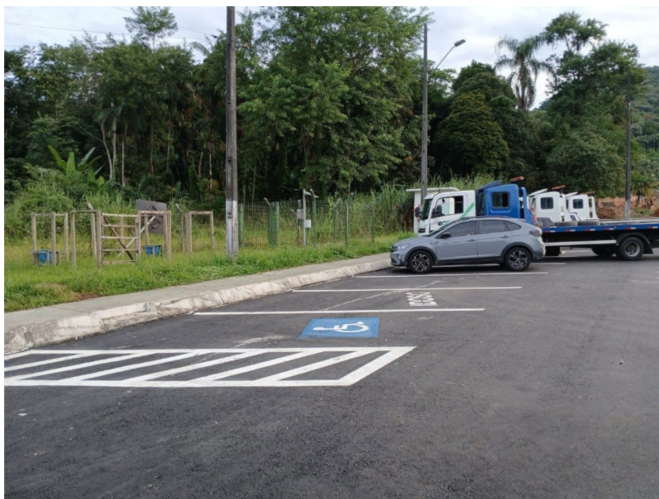
Imagem 11 – Estacionamento Veículos Leves
