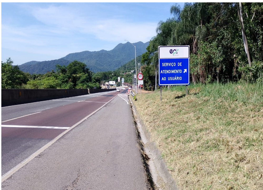
Imagem 9 – Sinalização Taper Entrada
