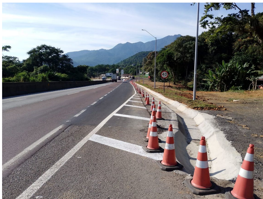
Imagem 6 – Sistema de Drenagem
