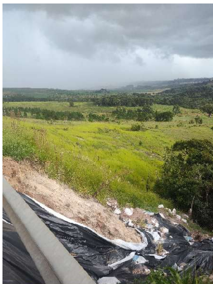
Figura 10. Detalhe do talude vistoriado.
