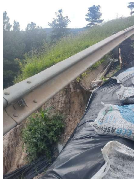
Figura 11. Detalhe do talude vistoriado.
