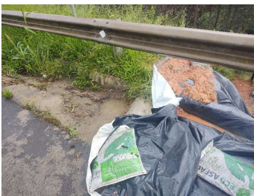
Figura 9. Detalhe do talude vistoriado.
