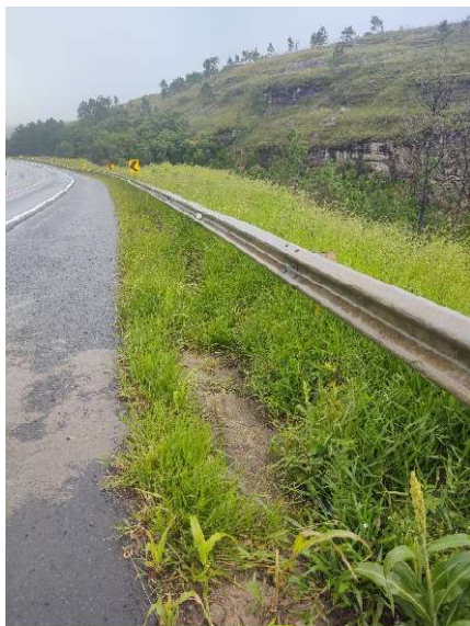
Figura 6. Detalhe do talude vistoriado.
