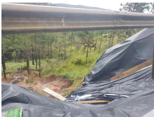
Figura 8. Detalhe do talude vistoriado.
