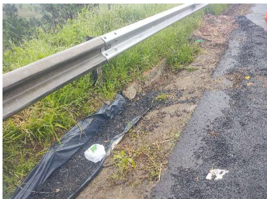
Figura 10. Detalhe do talude vistoriado.
