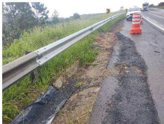
Figura 11. Detalhe do talude vistoriado.
