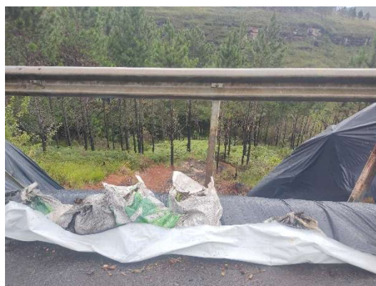
Figura 13. Detalhe do talude vistoriado.
