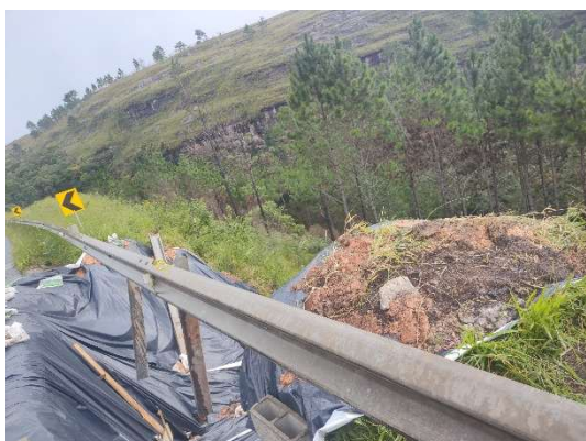
Figura 12. Detalhe do talude vistoriado.
