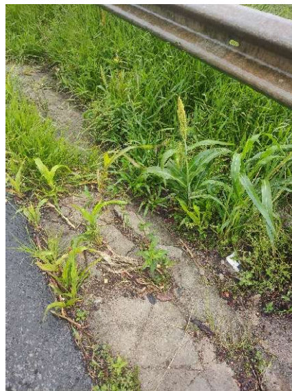
Figura 7. Detalhe do talude vistoriado.
