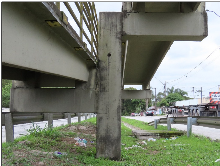
FOTO 049 Vista do pilar P4, face Norte.
