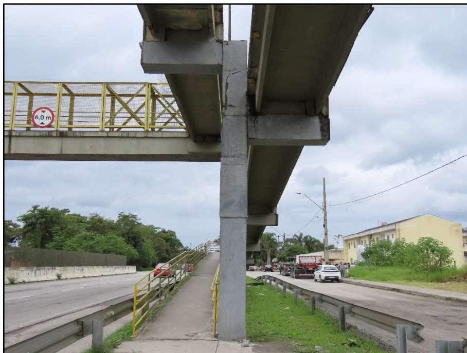
FOTO 047 Vista do pilar P2, face Norte.
