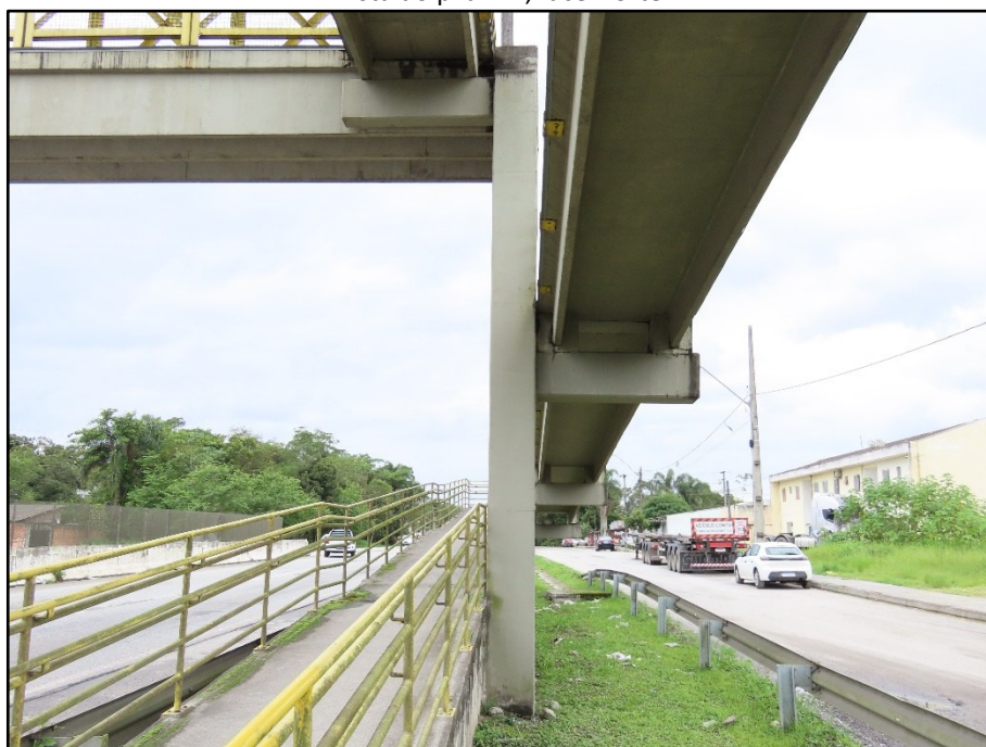
FOTO 048 Vista do pilar P3, face Norte.
