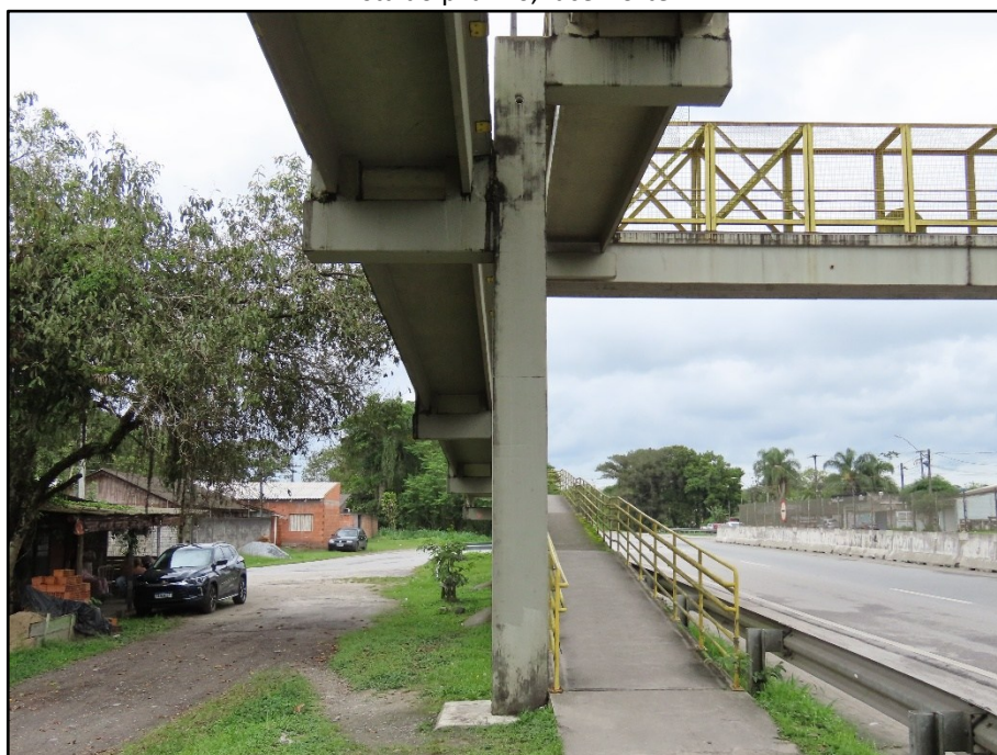
FOTO 052 Vista do pilar P7, face Norte.
