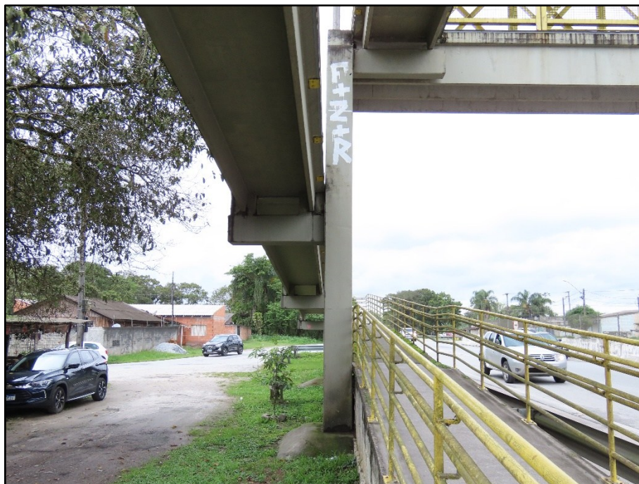
FOTO 053 Vista do pilar P8, face Norte.
