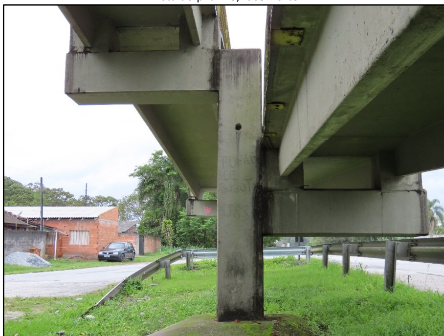
FOTO 054 Vista do pilar P9, face Norte.
