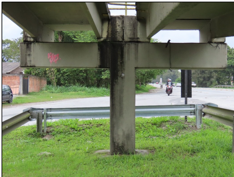
FOTO 055 Vista do pilar P10, face Norte.
