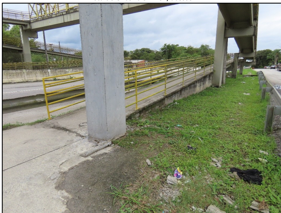
FOTO 058 Vista do muro lateral Oeste, acesso1.
