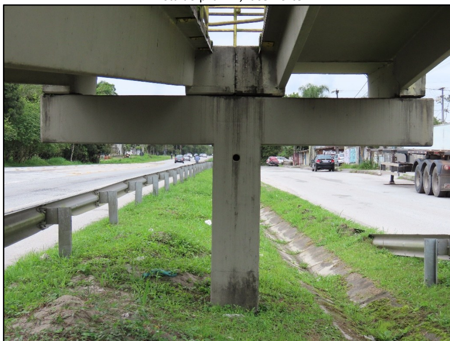
FOTO 050 Vista do pilar P5, face Norte.
