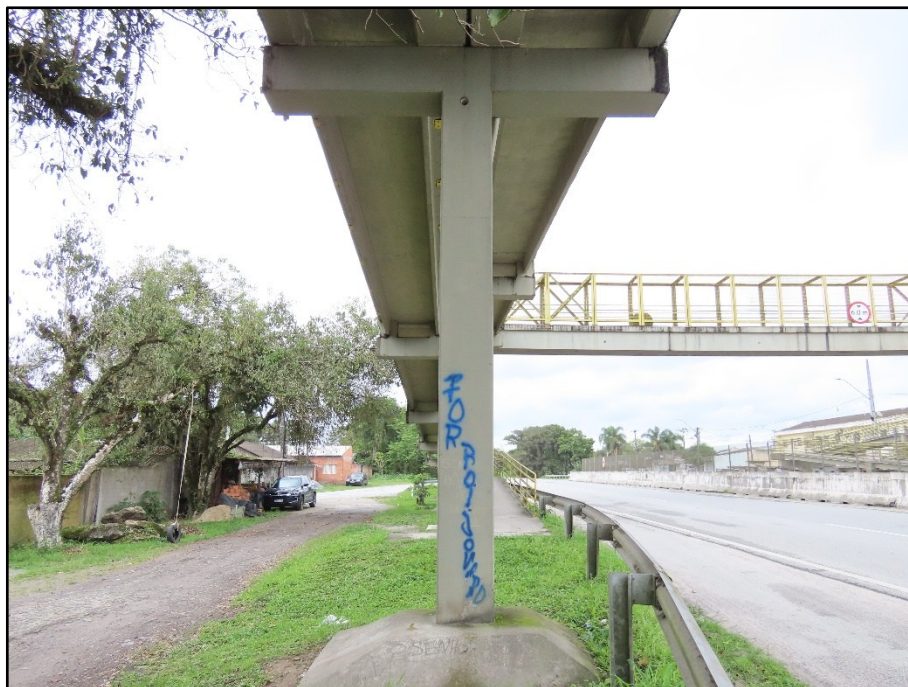
FOTO 051 Vista do pilar P6, face Norte.
