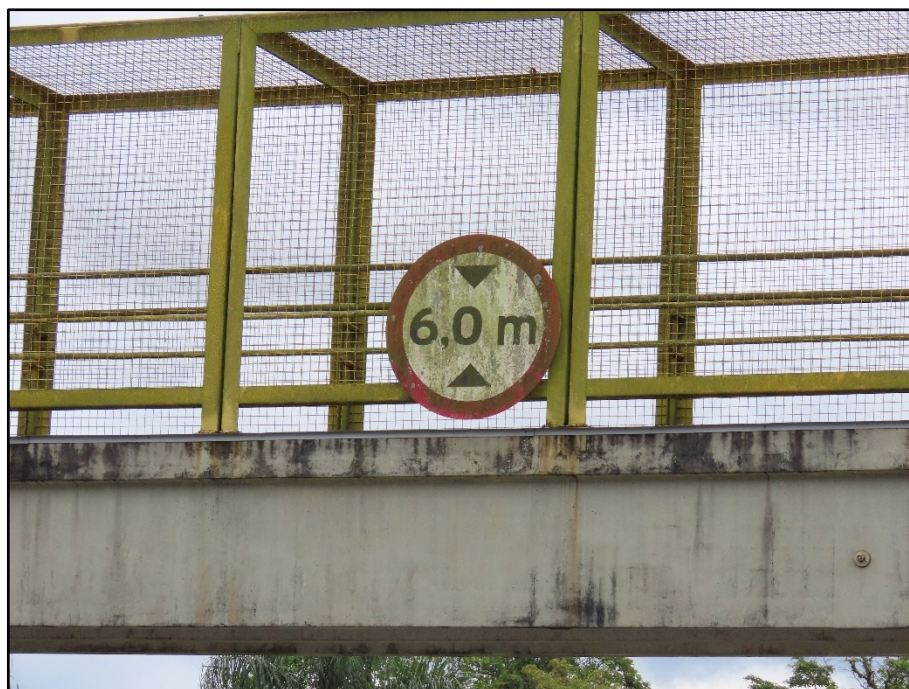
FOTO 081 Vista do gabarito vertical
