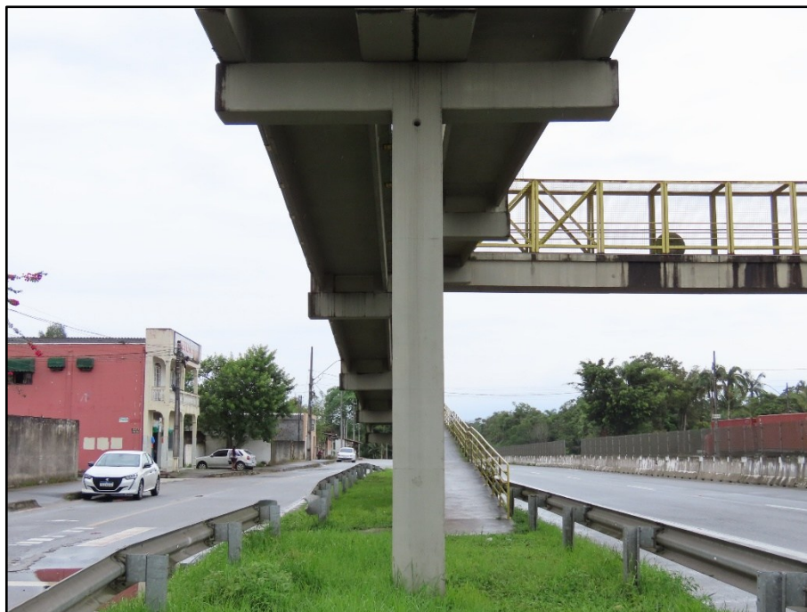
FOTO 051 Vista do pilar P6, face Norte.
