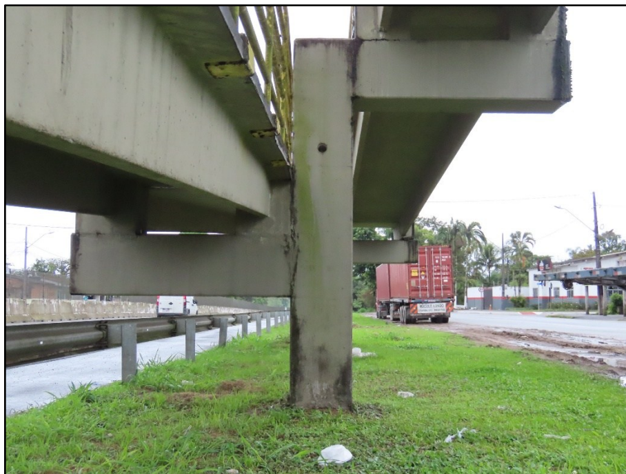
FOTO 049 Vista do pilar P4, face Norte.
