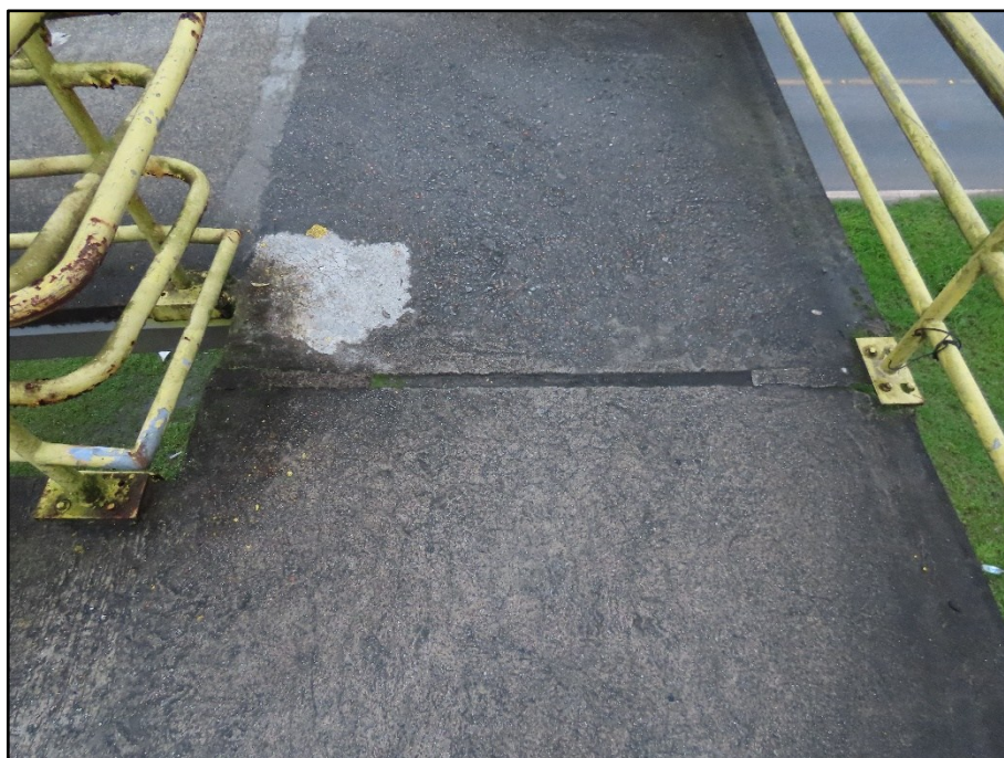
FOTO 271 Junta de dilatação JD7 com vedação, face Superior
