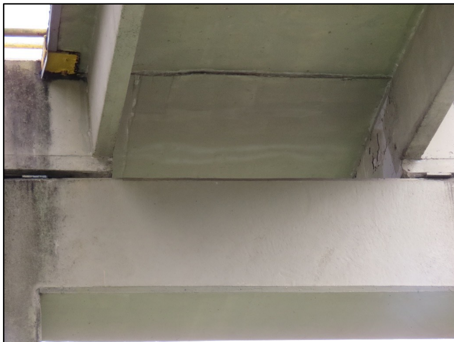
FOTO 174 AA's das NV1 e NV2, no pilar P6, rampa 11
