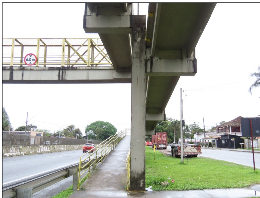
FOTO 047 Vista do pilar P2, face Norte.
