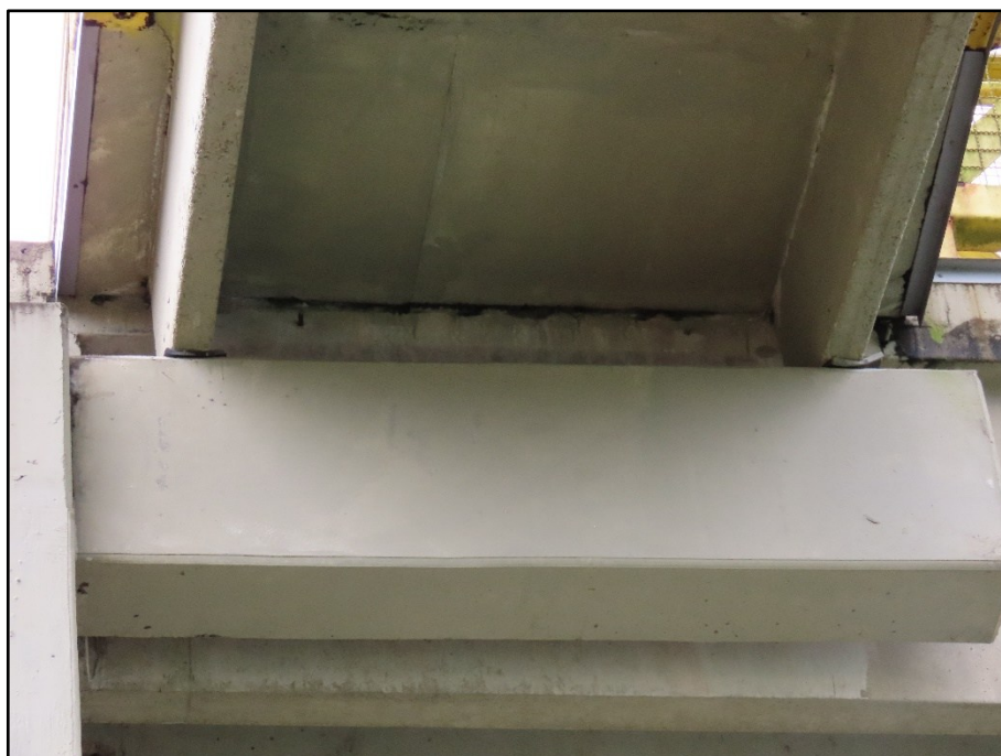
FOTO 183 AA's das NV1 e NV2, no pilar P8, rampa 9
