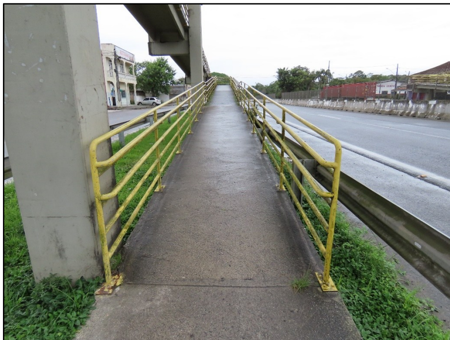
FOTO 057 Vista do encontro ENC2, acesso2.
