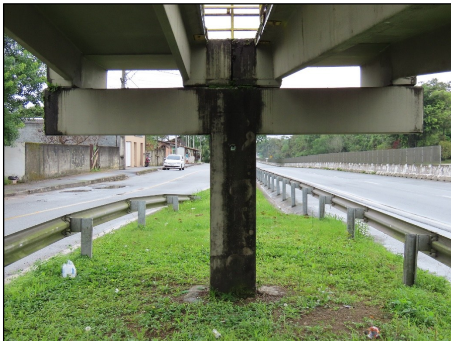
FOTO 055 Vista do pilar P10, face Norte.
