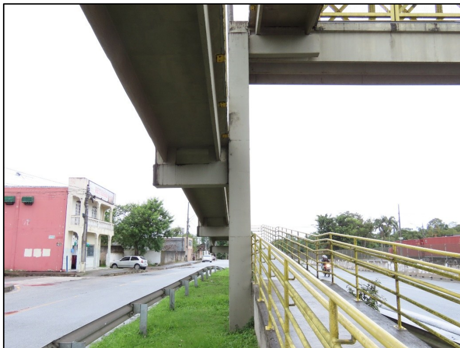
FOTO 053 Vista do pilar P8, face Norte.
