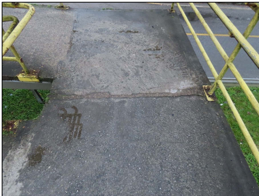
FOTO 276 Junta de dilatação JD16 com vedação, face Superior
