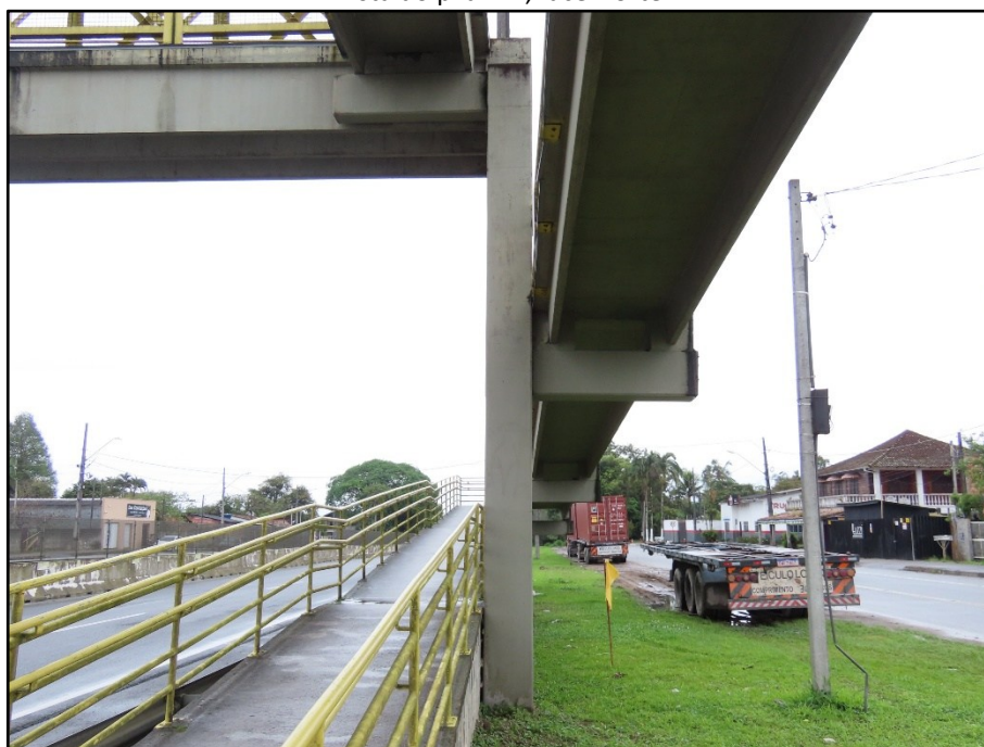
FOTO 048 Vista do pilar P3, face Norte.
