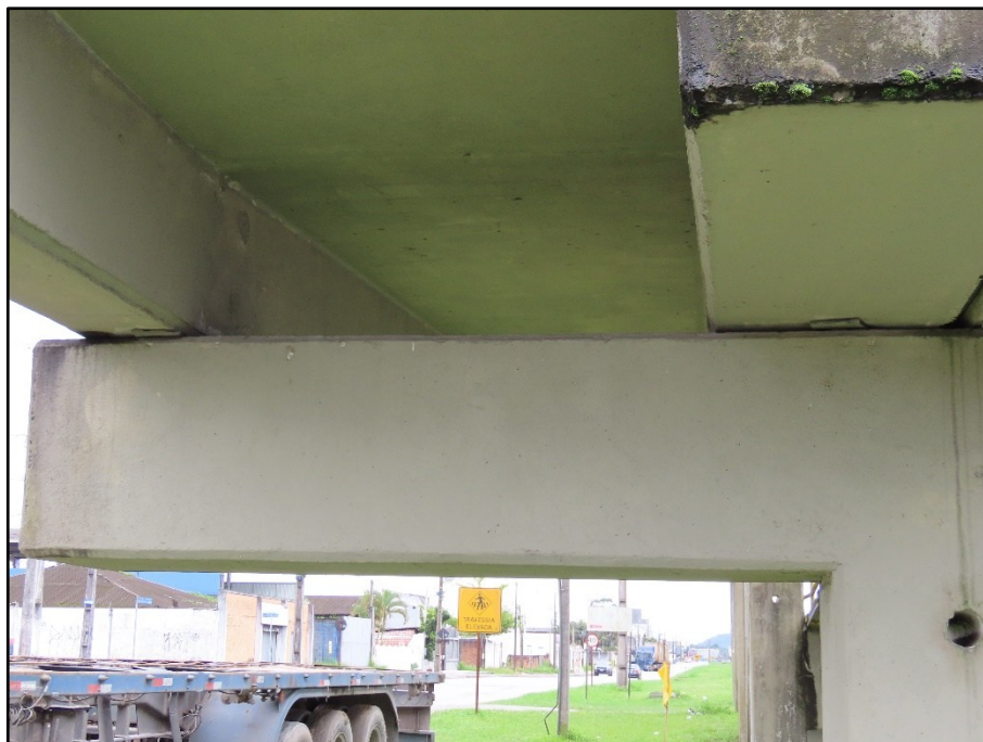
FOTO 168 AA's das NV1 e NV2, no pilar P5, rampa 3
