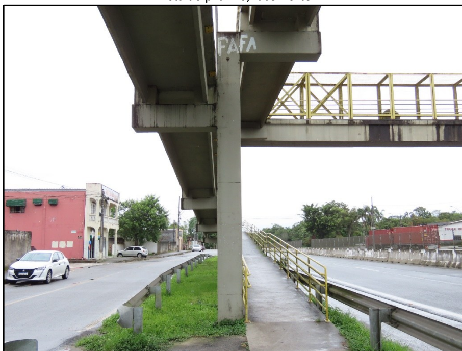
FOTO 052 Vista do pilar P7, face Norte.
