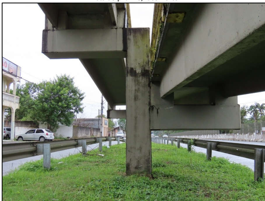
FOTO 054 Vista do pilar P9, face Norte.
