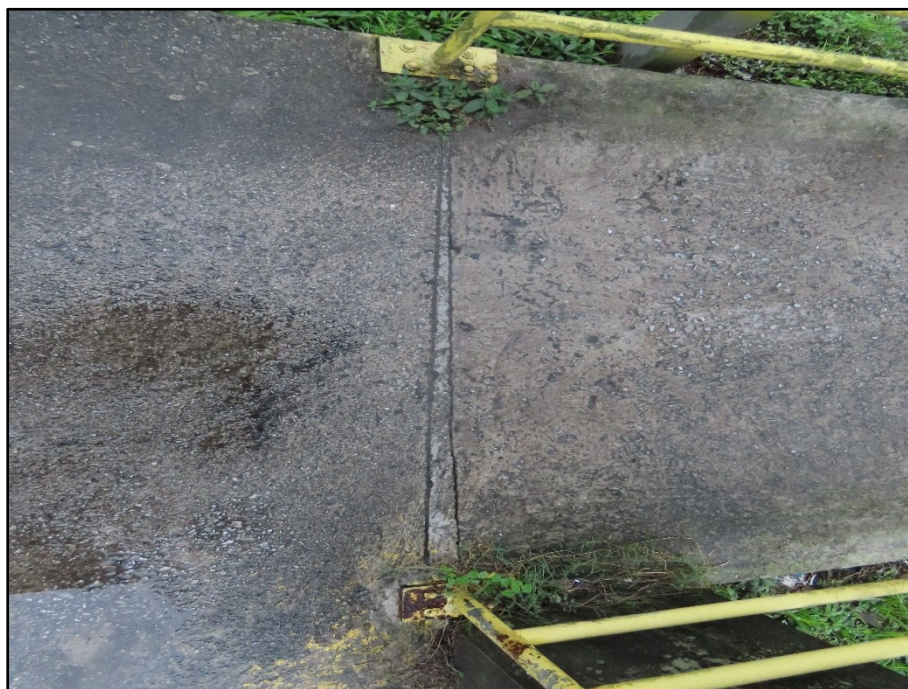
FOTO 061 Vista da junta do ENC1.
