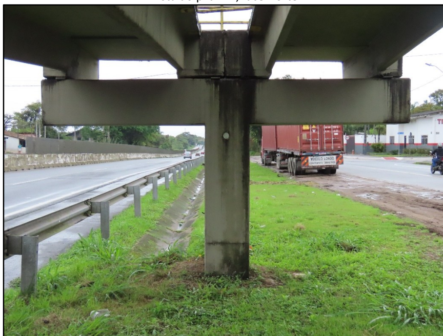
FOTO 050 Vista do pilar P5, face Norte.
