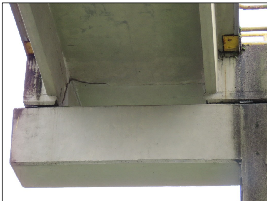
FOTO 171 AA's das NV1 e NV2, no pilar P6, rampa 10
