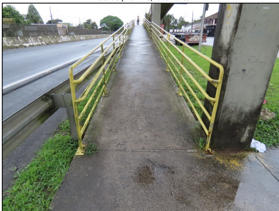
FOTO 056 Vista do encontro ENC1, acesso1.
