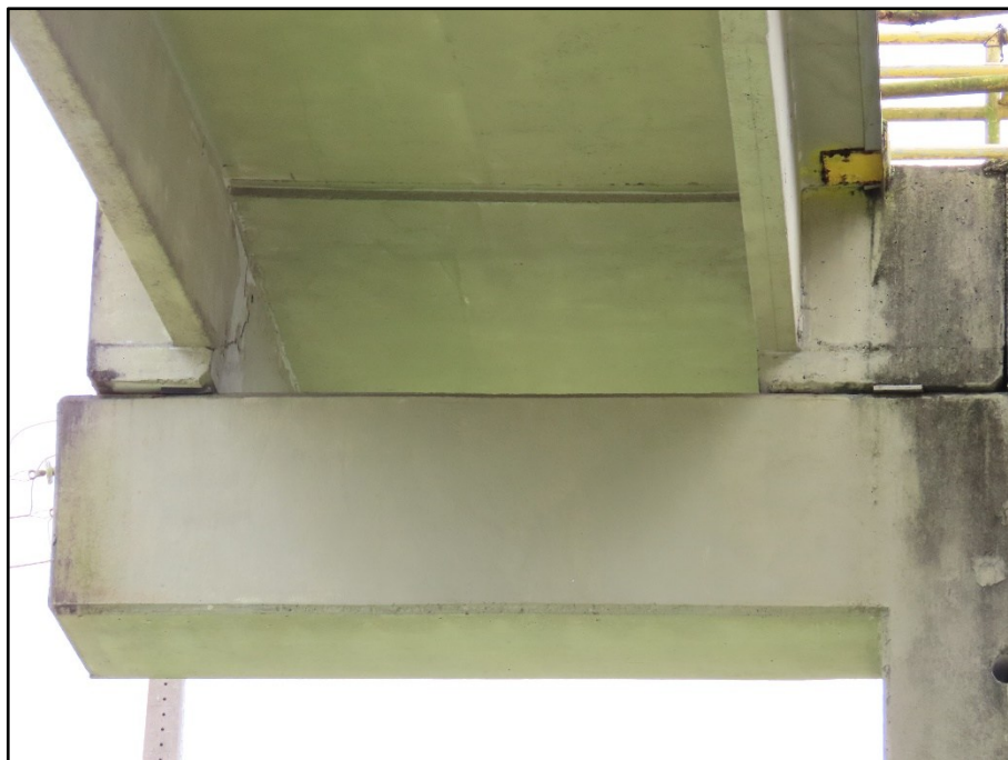
FOTO 158 AA's das NV1 e NV2, no pilar P1, rampa 6
