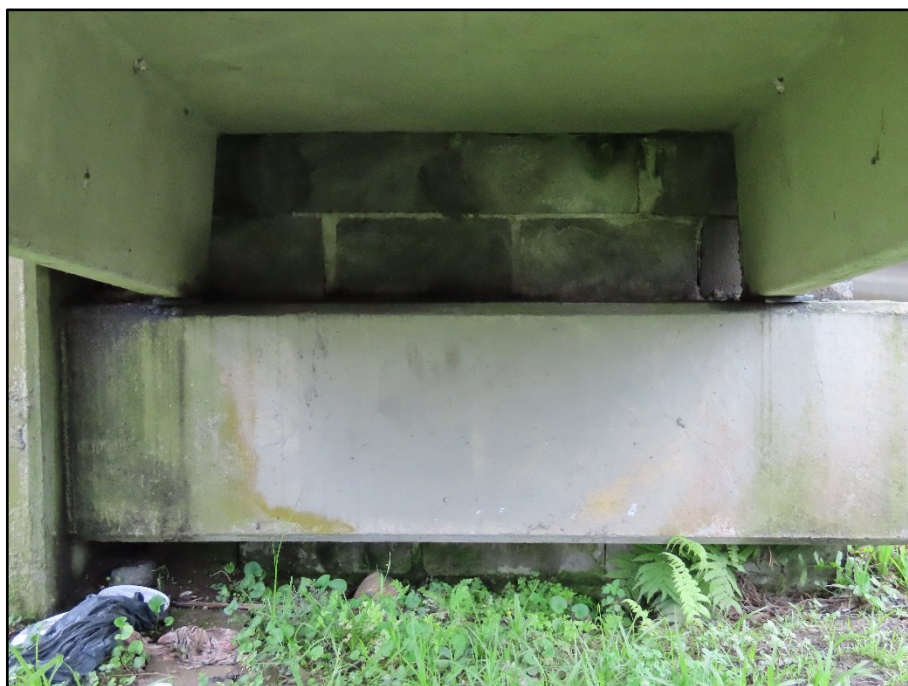
FOTO 177 AA's das NV1 e NV2, no pilar P3, rampa 1
