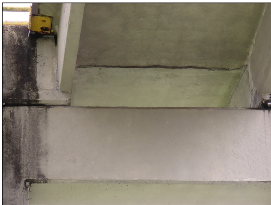
FOTO 161 AA's das NV1 e NV2, no pilar P1, rampa 7
