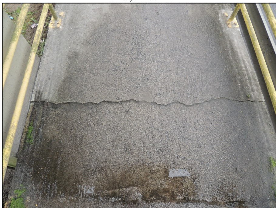
FOTO 060 Vista da junta J1.
