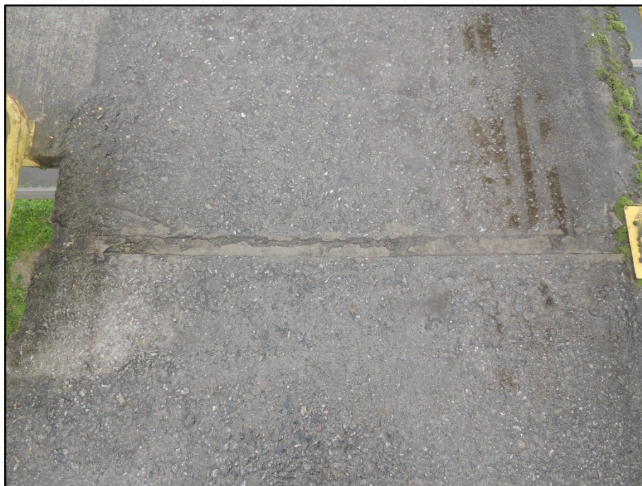
FOTO 071 Vista da junta de dilatação JD12.
