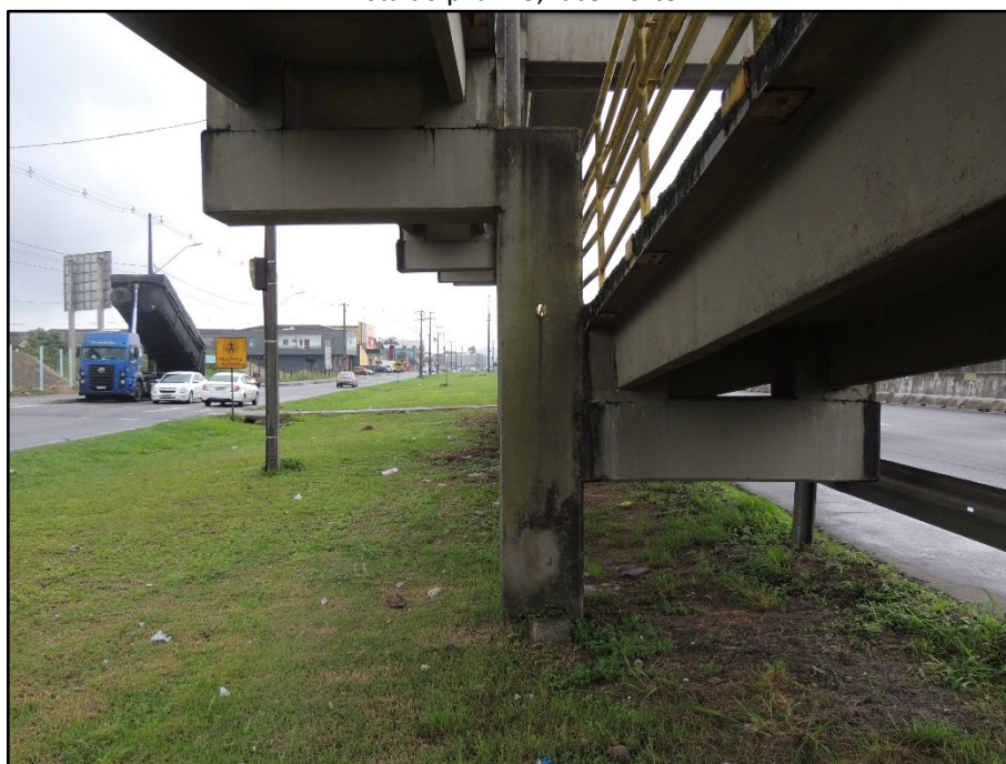
FOTO 048 Vista do pilar P4, face Sul.
