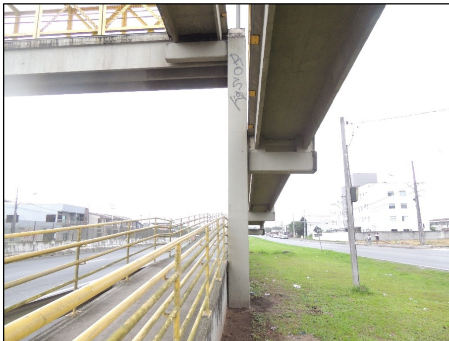
FOTO 047 Vista do pilar P3, face Norte.
