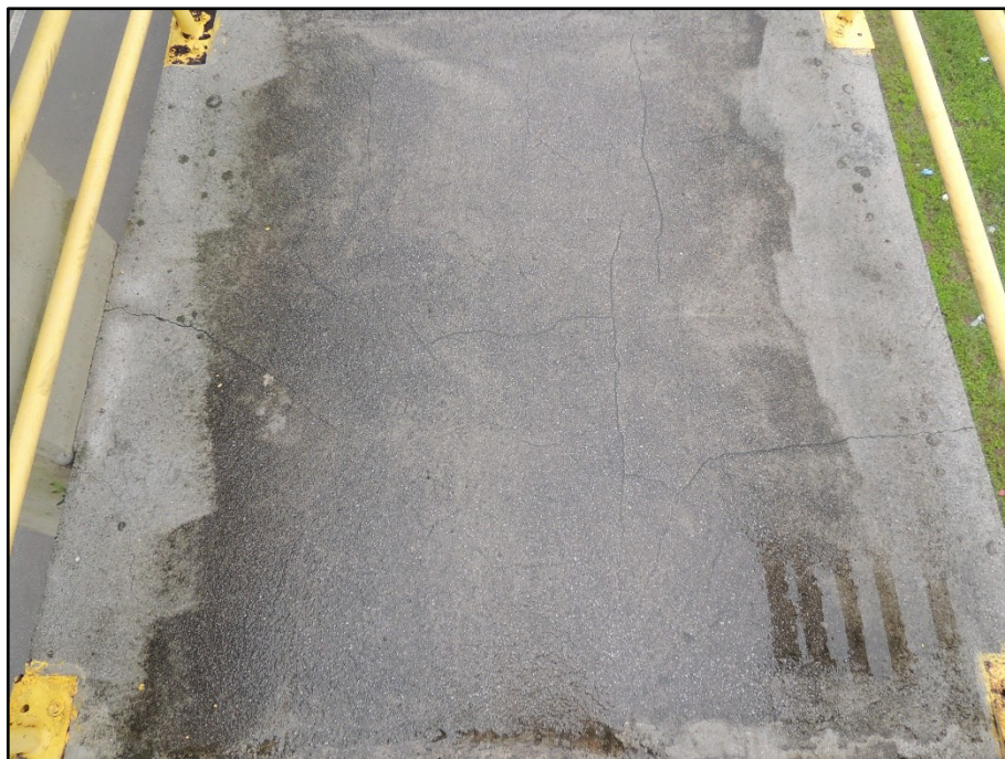
FOTO 065 Vista da junta J6.
