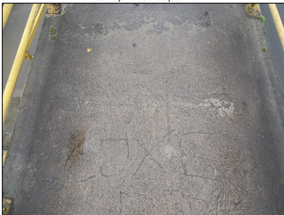
FOTO 070 Vista da junta J11.
