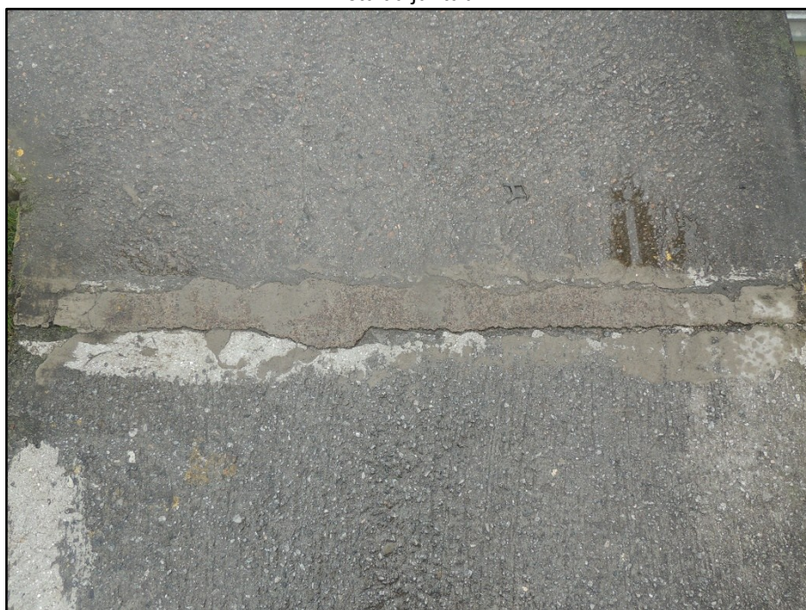
FOTO 062 Vista da junta de dilatação JD3.
