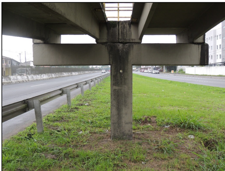
FOTO 049 Vista do pilar P5, face Norte.
