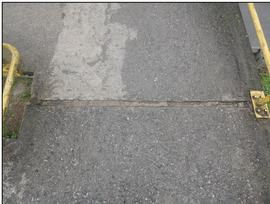
FOTO 075 Vista da junta de dilatação JD16.
