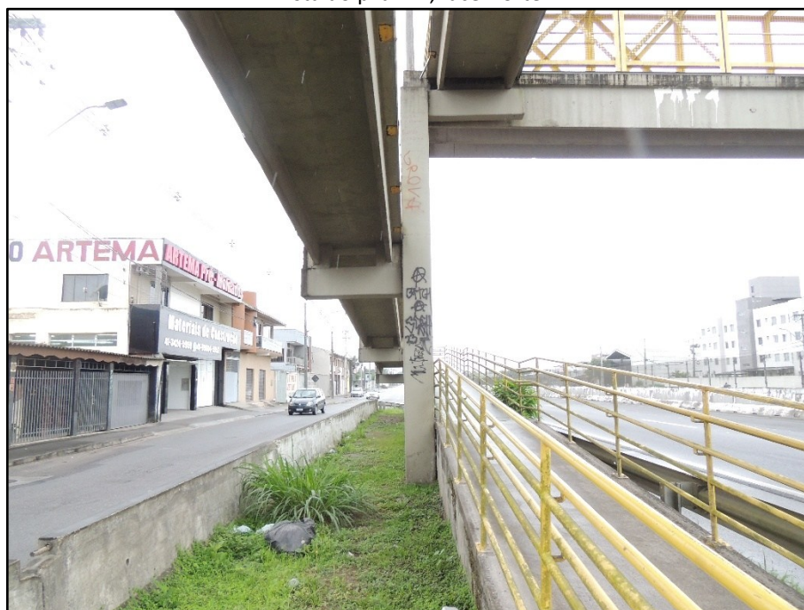
FOTO 052 Vista do pilar P8, face Norte.
