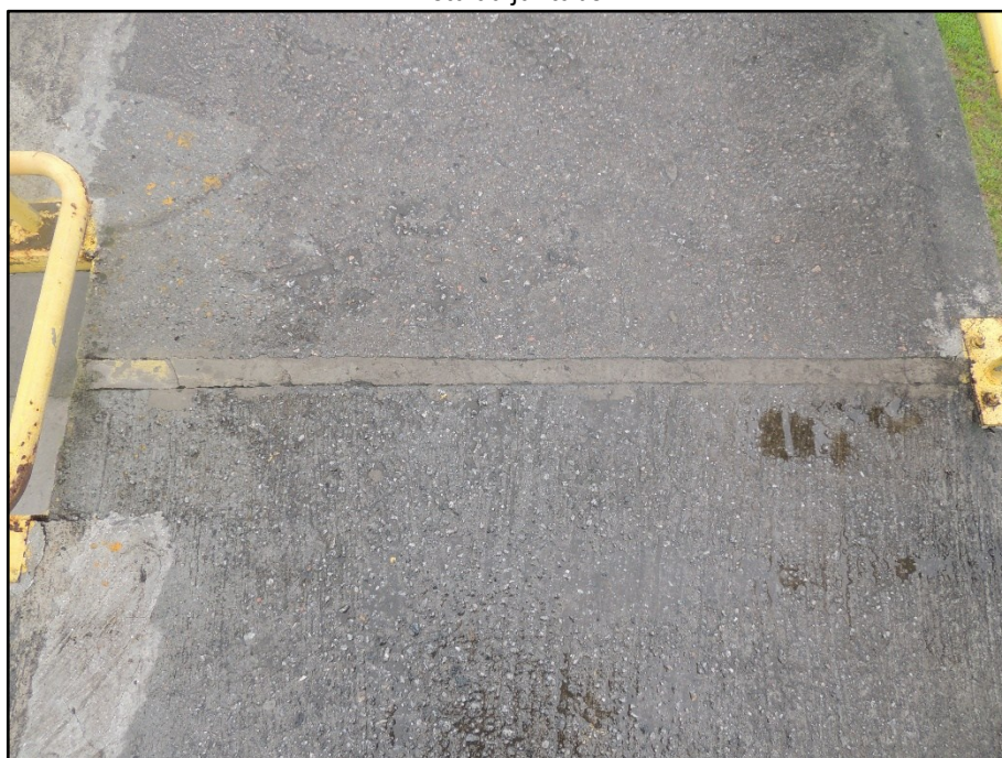
FOTO 066 Vista da junta de dilatação JD7.
