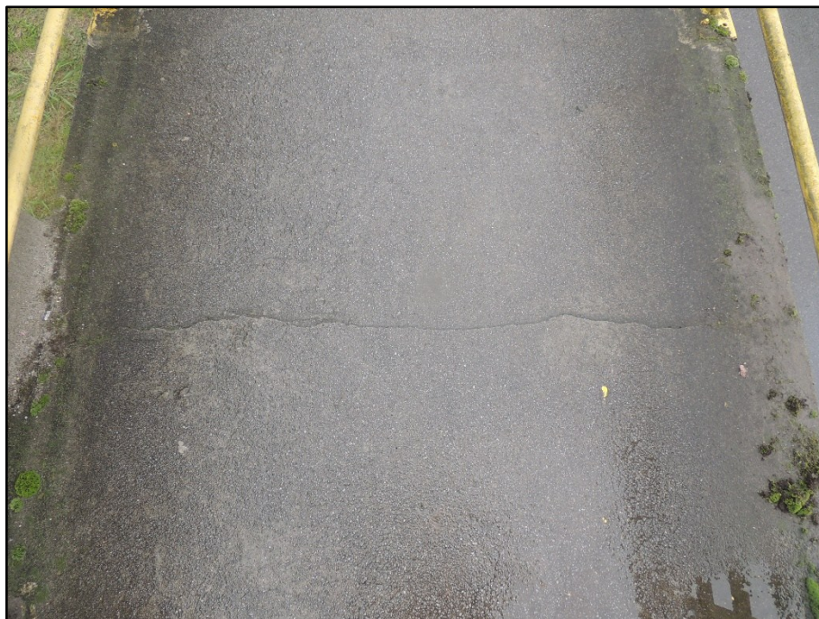
FOTO 061 Vista da junta J2.
