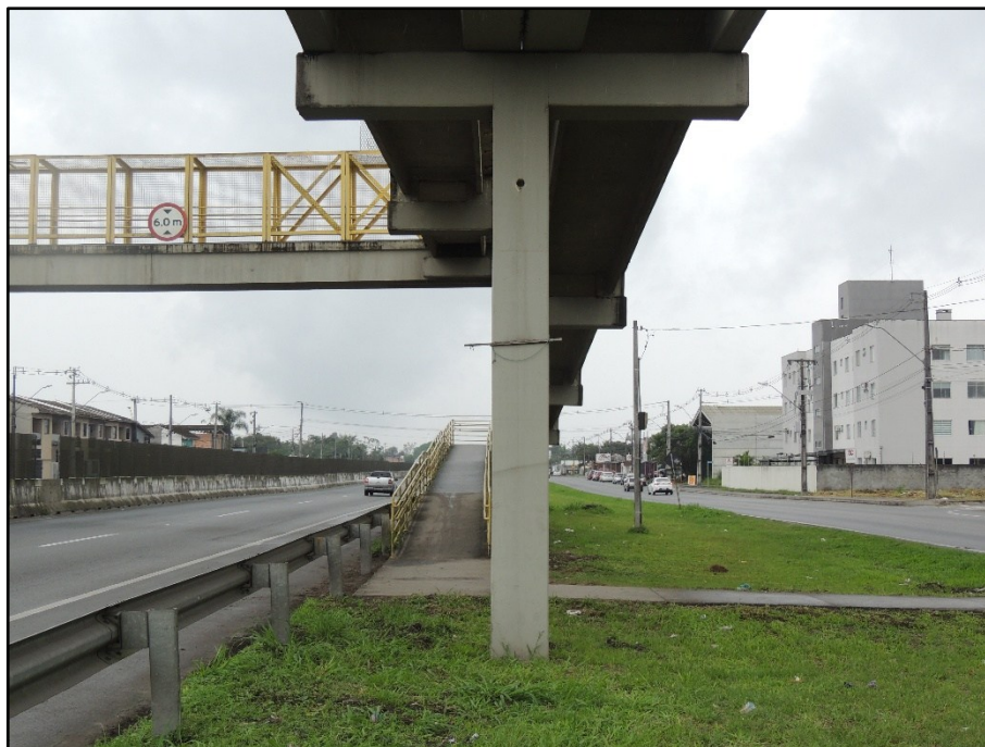
FOTO 045 Vista do pilar P1, face Norte.
