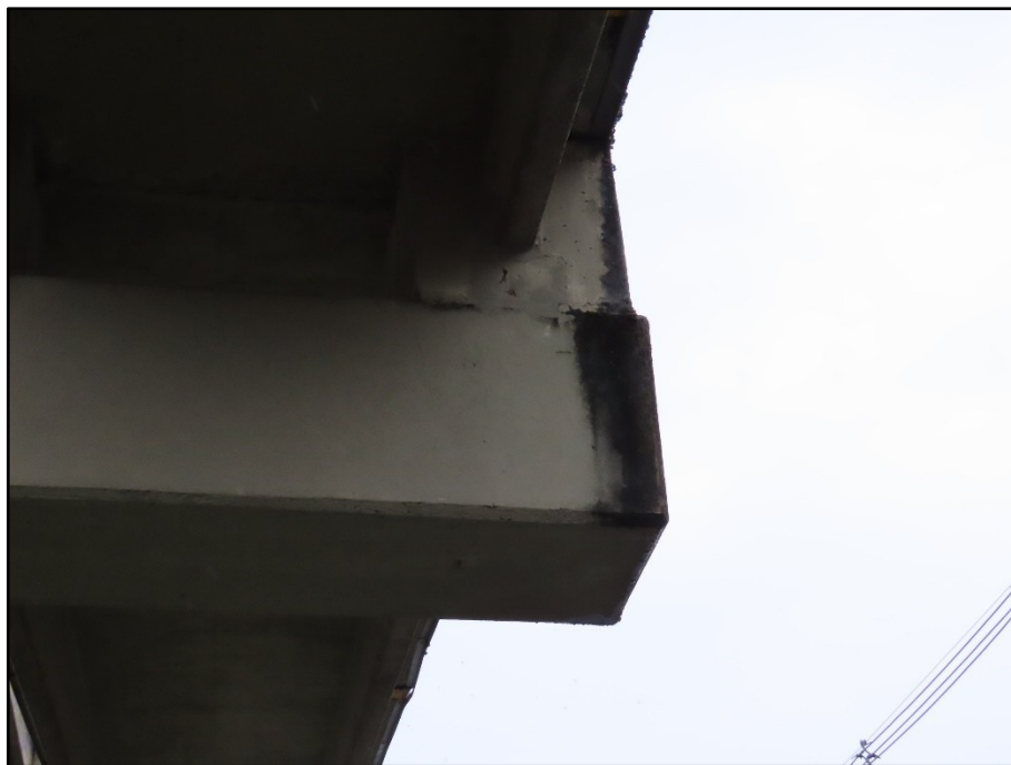
Foto 253 Manchas de umidade na VAP18 do pilar P8, face Sul.
