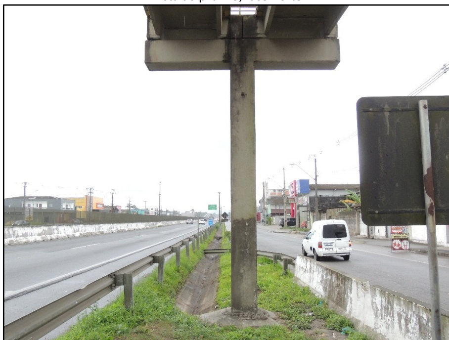
FOTO 050 Vista do pilar P6, face Sul.
