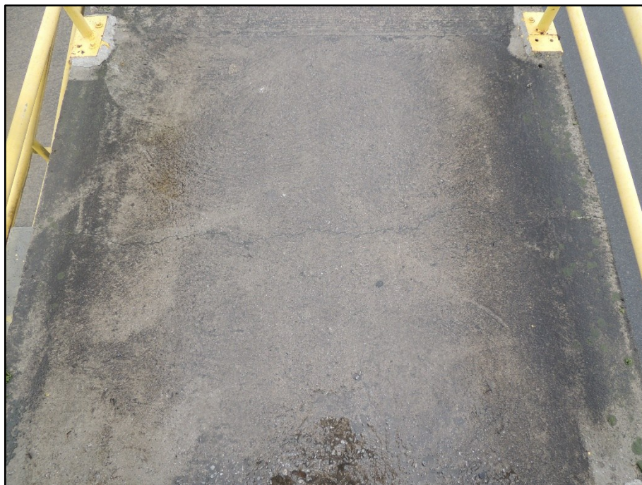
FOTO 067 Vista da junta J8.
