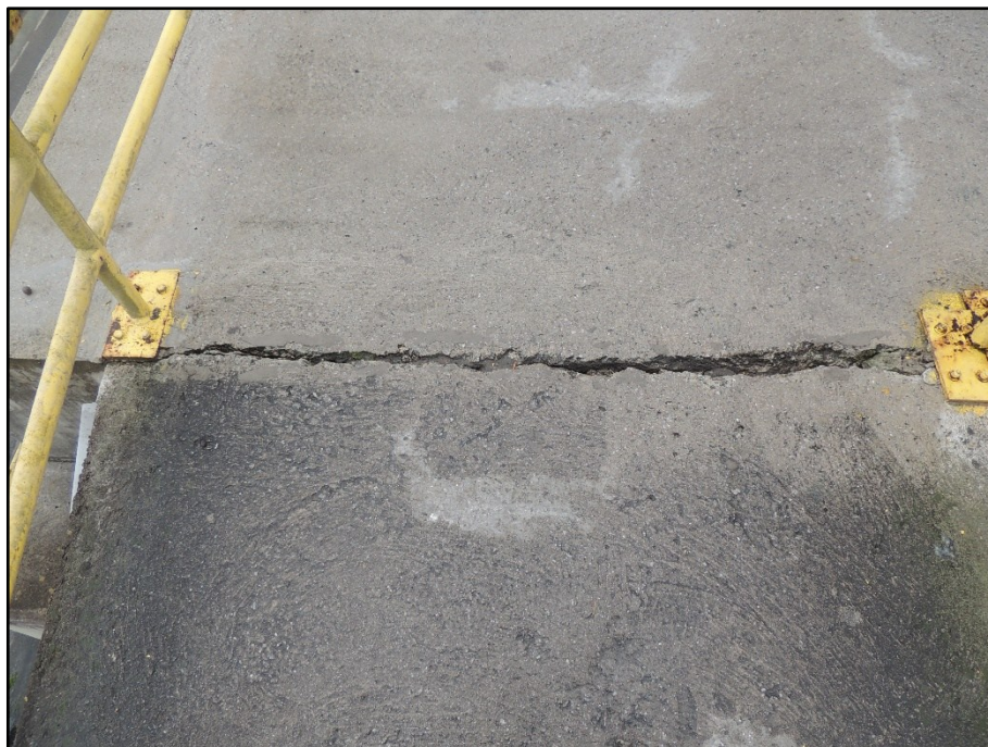
FOTO 069 Vista da junta de dilatação JD10.
