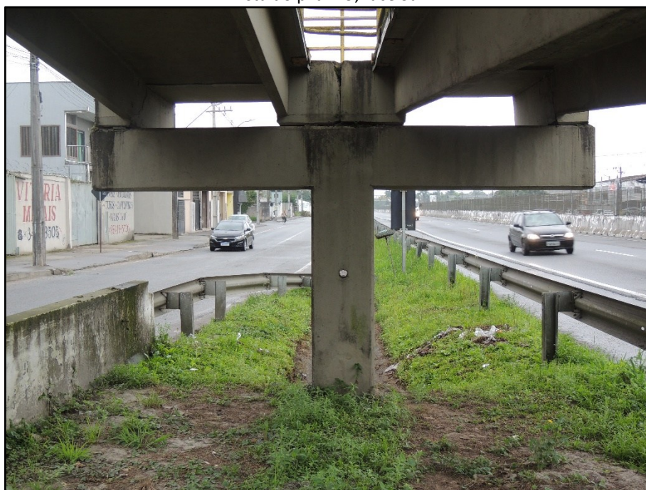
FOTO 054 Vista do pilar P10, face Norte.
