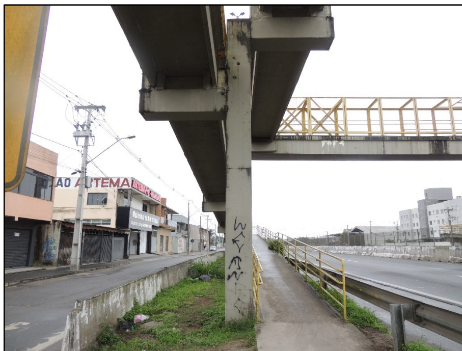
FOTO 051 Vista do pilar P7, face Norte.
