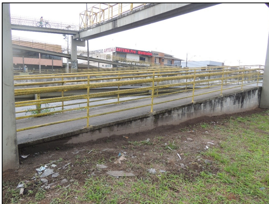
FOTO 057 Vista do muro lateral Oeste, acesso1.
