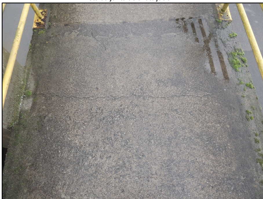
FOTO 072 Vista da junta J13.
