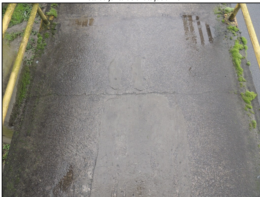
FOTO 076 Vista da junta J17.
