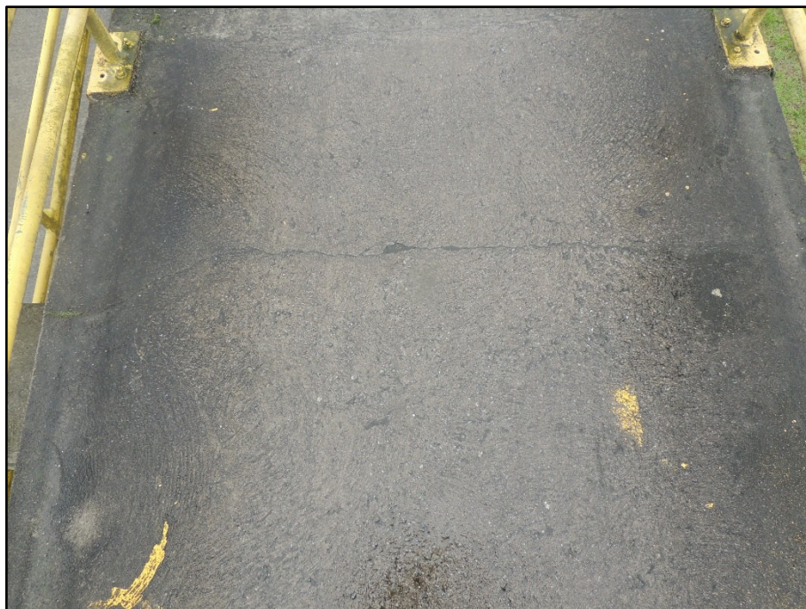
FOTO 063 Vista da junta J4.
