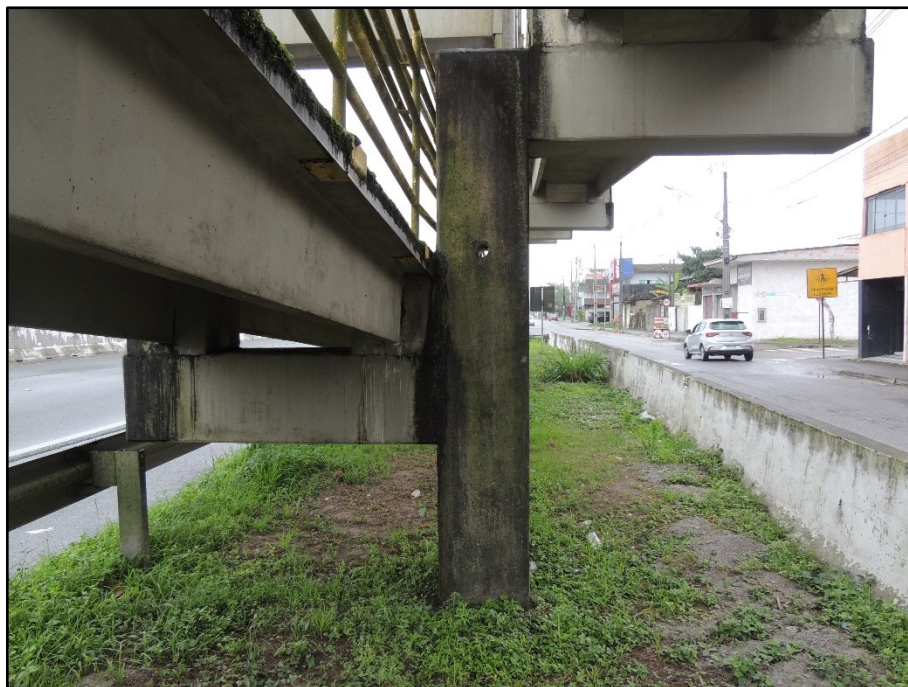
FOTO 053 Vista do pilar P9, face Sul.
