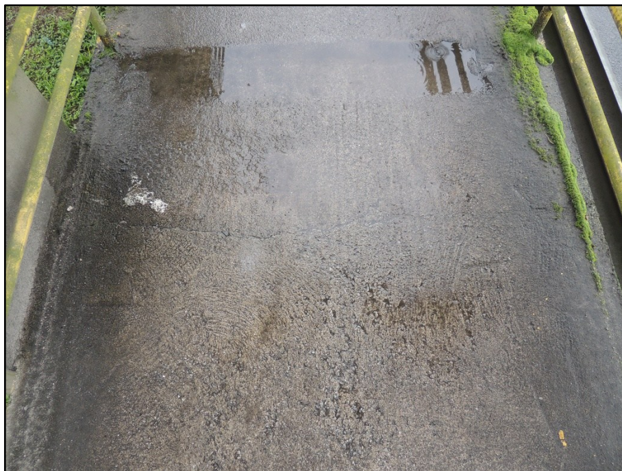
FOTO 077 Vista da junta J18.
