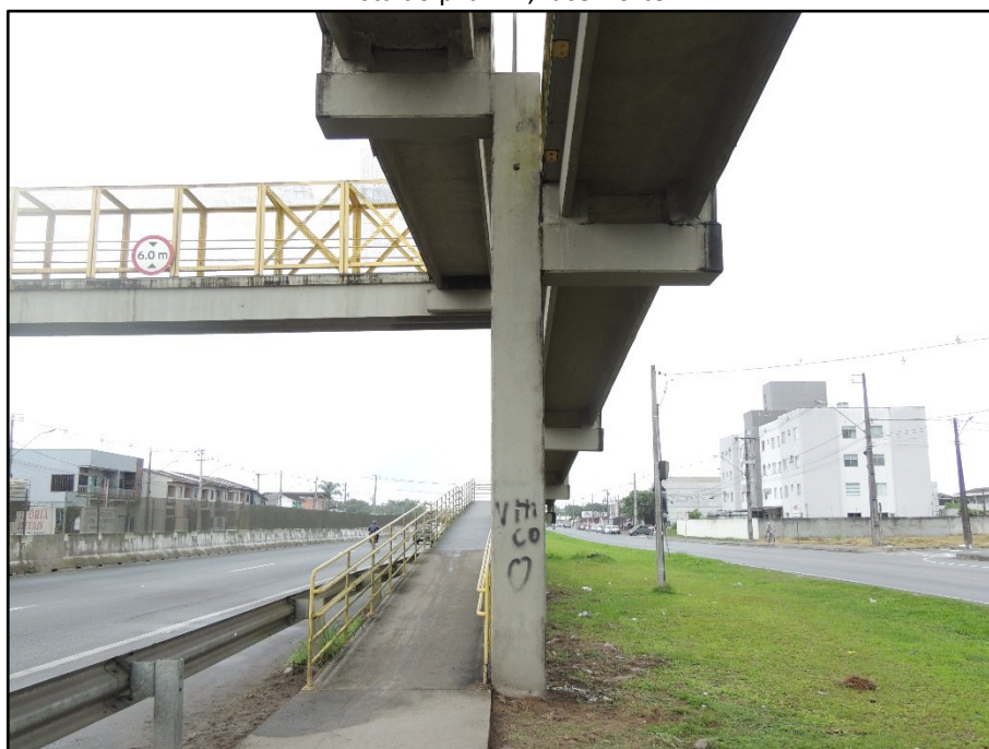
FOTO 046 Vista do pilar P2, face Norte.
