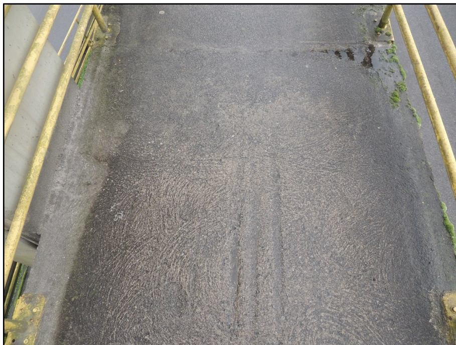
FOTO 073 Vista da junta J14.
