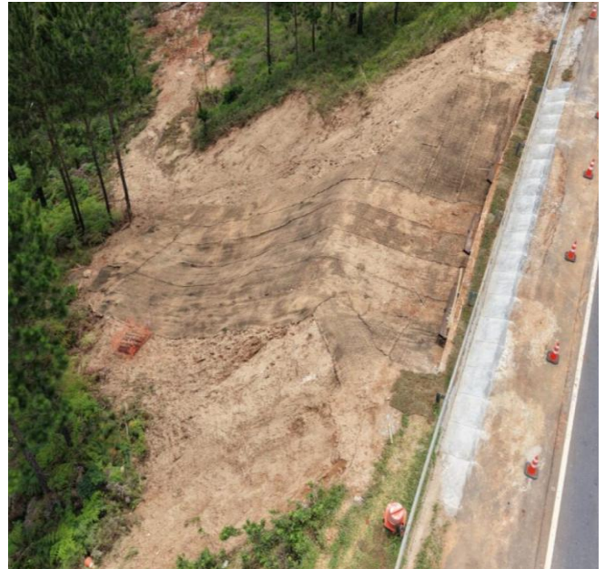
VISÃO PROTEÇÃO SUPERFICIAL Km 236+600
