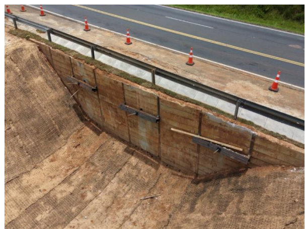
VISÃO CONTENÇÃO TRECHO Km 236+600
