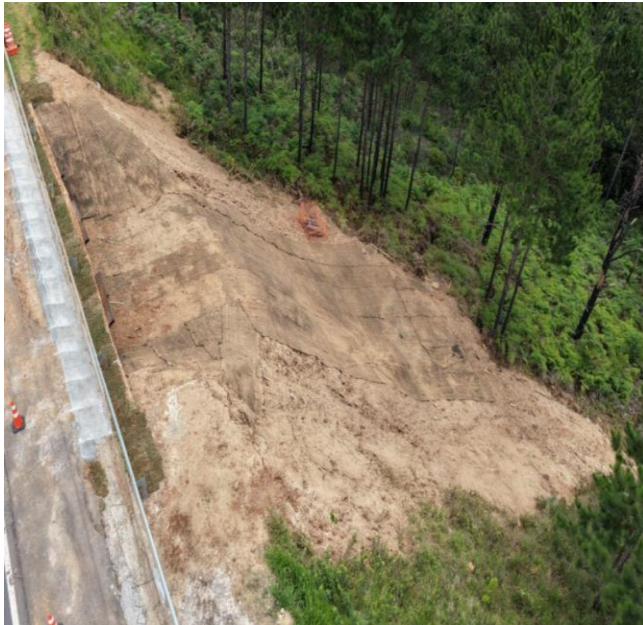
VISÃO PROTEÇÃO SUPERFICIAL Km 236+600
