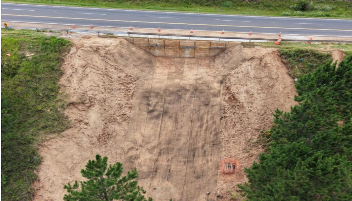
VISÃO GERAL DO TRECHO Km 236+600
