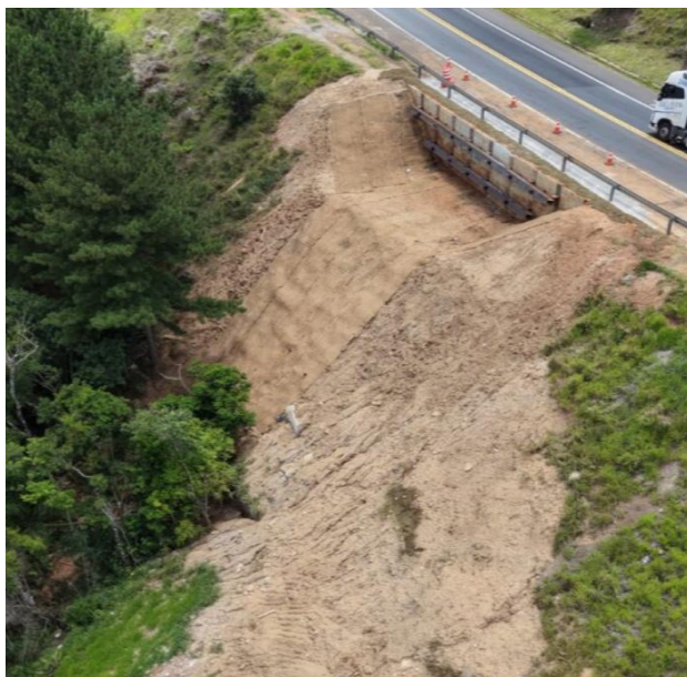
VISÃO PROTEÇÃO SUPERFICIAL Km 234+700
