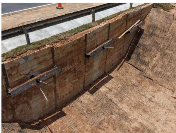
VISÃO CONTENÇÃO TRECHO Km 236+600
