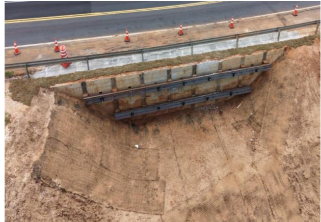
VISÃO CONTENÇÃO TRECHO Km 234+700
