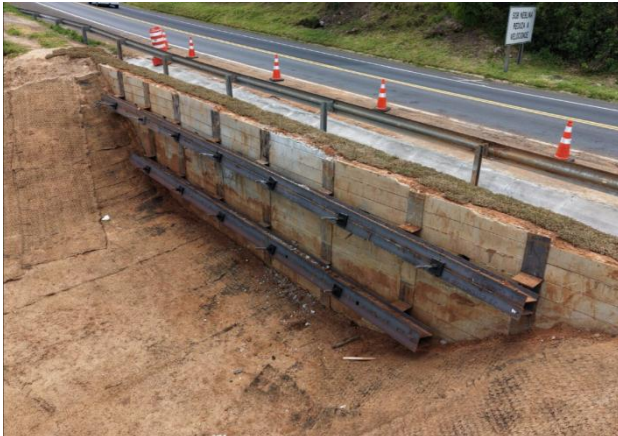
VISÃO CONTENÇÃO TRECHO Km 234+700
