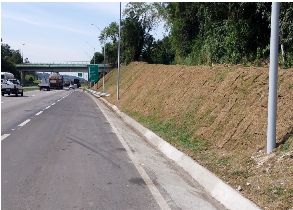
Imagem 7 – Sistema de Drenagem
