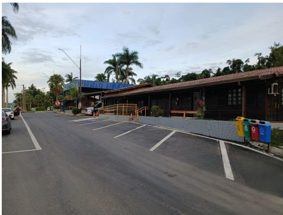
Imagem 11 – Estacionamento Veículos Leves
