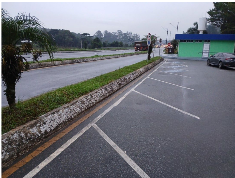
Imagem 11 – Estacionamento Veículos Leves
