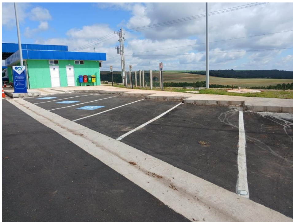
Imagem 11 – Estacionamento Veículos Leves
