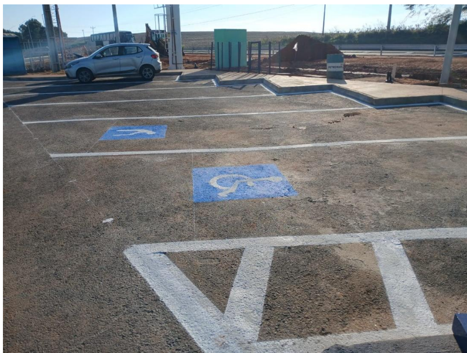
Imagem 11 – Estacionamento Veículos Leves
