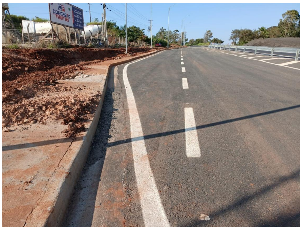
Imagem 12 – Estacionamento Veículos Pesados
