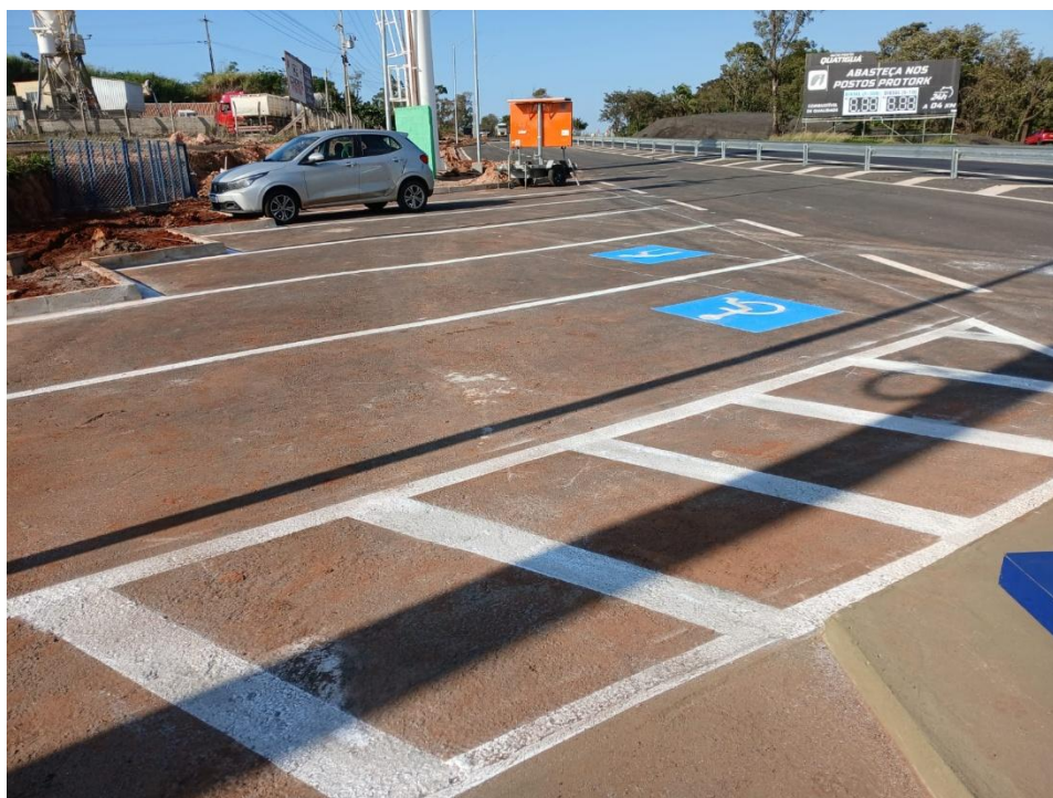
Imagem 11 – Estacionamento Veículos Leves
