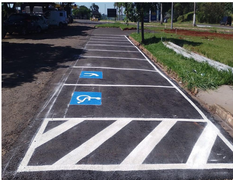
Imagem 11 – Estacionamento Veículos Leves
