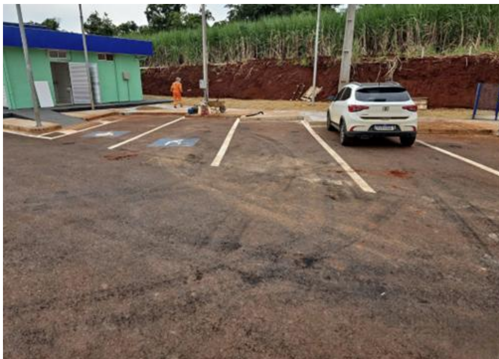
Imagem 11 – Estacionamento Veículos Leves
