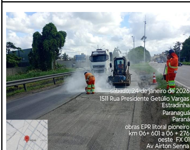
Av. Ayrton Senna Oeste – km 06+601 ao km 06+276
