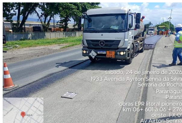
Av. Ayrton Senna Oeste – km 06+601 ao km 06+276
