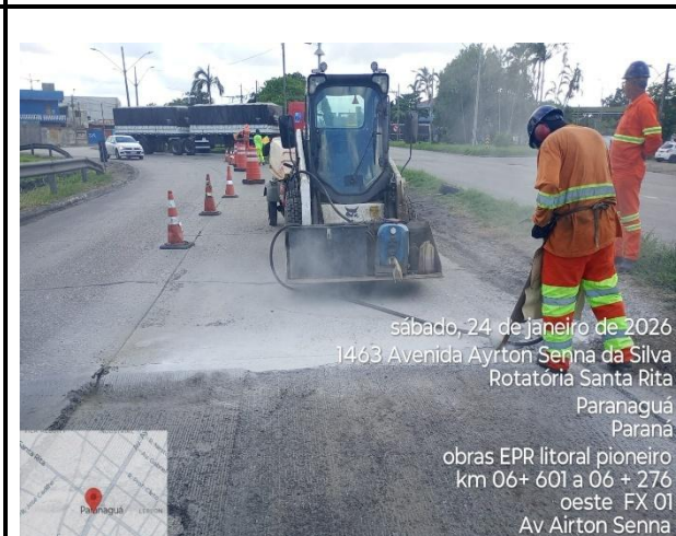
Av. Ayrton Senna Oeste – km 06+601 ao km 06+276
