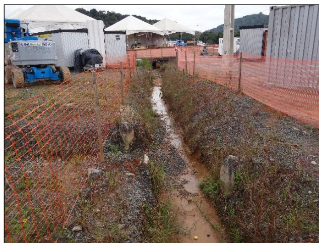
Figura 3.21. Canaleta de drenagem escavada em meio à um canteiro de obras.
