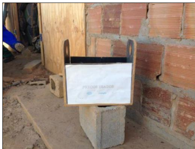
Figura 3.9. Contentores de fabricação própria utilizados para segregação de resíduos, sendo à esquerda para acondicionamento de papel e plástico e à direita caixa para coleta de pregos.
