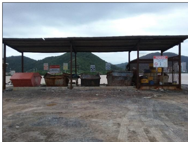
Figura 3.7. Modelo de central de armazenamento de resíduo com uso de caçamba brooks.
