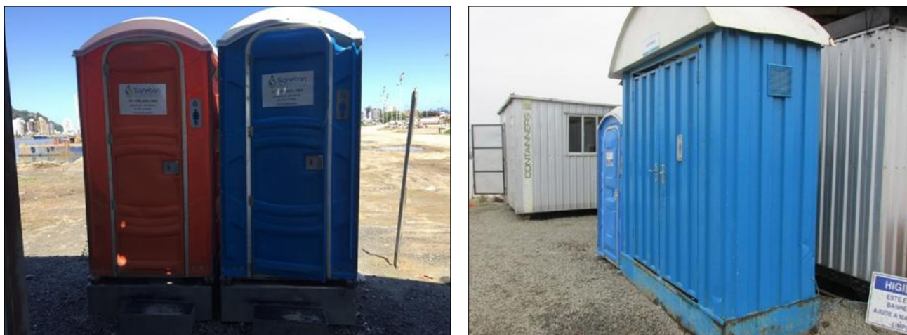
Figura 3.10. Exemplo de banheiros químicos utilizados em canteiro de obras.
