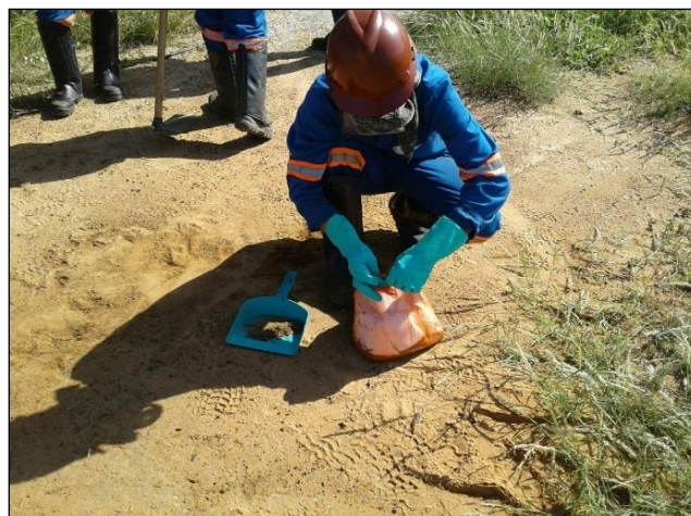
Figura 3.4. Procedimento de remoção e acondicionamento de solo contaminado, removido imediatamente após sua identificação.
