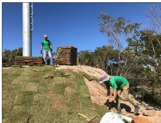
Figura 3.23. Revegetação de talude com o plantio de gramíneas em leivas, juntamente com aplicação de estaqueamento para sua fixação. Fonte: RM2 ENGENHARIA.
