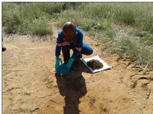
Figura 3.4. Procedimento de remoção e acondicionamento de solo contaminado, removido imediatamente após sua identificação.
