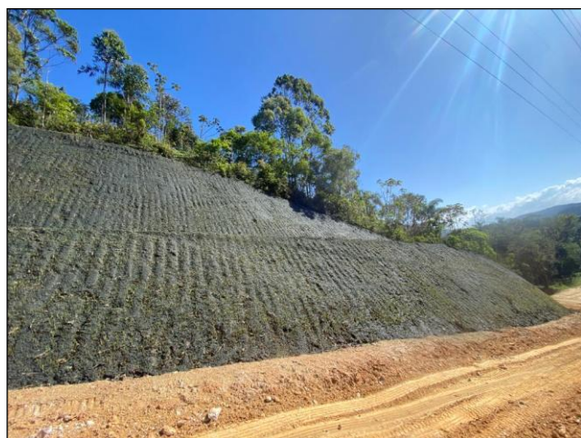
Figura 3.22. Revegetação de encosta com a aplicação da técnica de hidrossemeadura. Fonte: RM2 ENGENHARIA.
