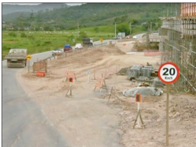
Figura 3.11. Placa de sinalização indicando a velocidade máxima próximo à um local de obras.
