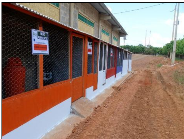
Figura 3.6. Modelo de baias de armazenamento de resíduos sólidos no canteiro de obras.
