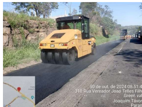
PR 092 Compactação km 306
