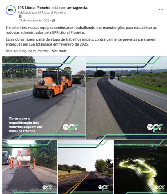
Figura 12 – Publicação expondo obras para a requalificação das rodovias administradas pela EPR Litoral Pioneiro.
