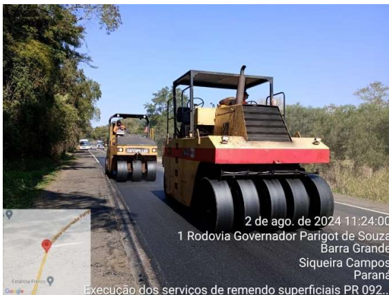
PR 092 Compactação km 286 ao km 287
