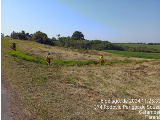
PR151 Km 304 ao Km 305
