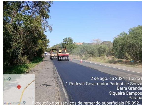
PR 092 Compactação km 286 ao km 287
