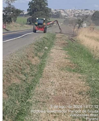
PR092 Km 60 ao km 50
