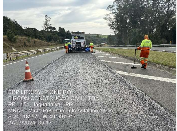
PR 151 km 223 ao km 220
