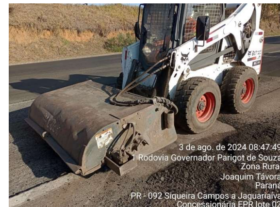
PR 092 Limpeza km 301
