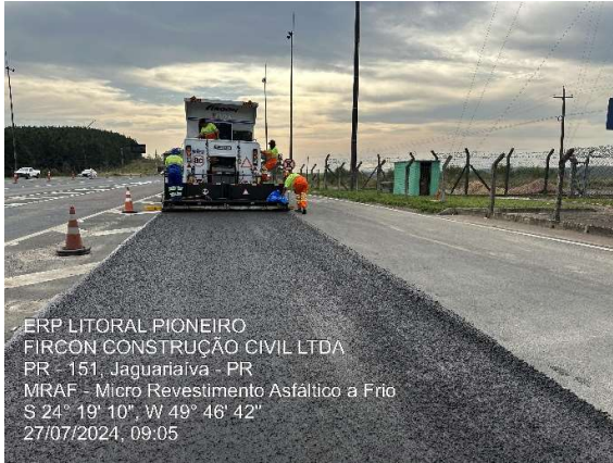
PR 151 km 223 ao km 220
