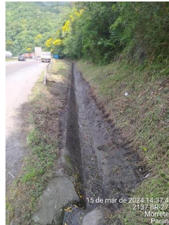
BR277 Limpeza de drenagens - Morretes
