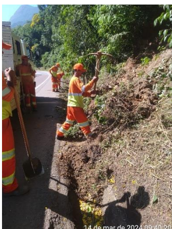
Limpeza de Drenagens – BR277
