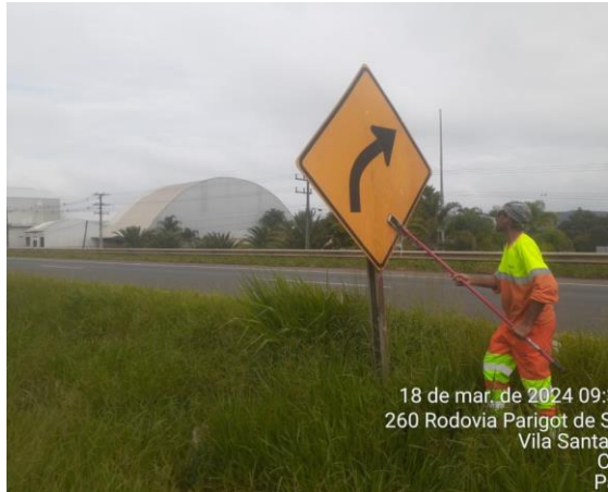
Limpeza de placas - PR151 trecho Castro
