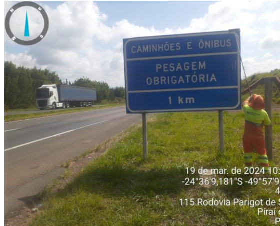
Limpeza de placas - PR151 trecho Pirai do Sul
