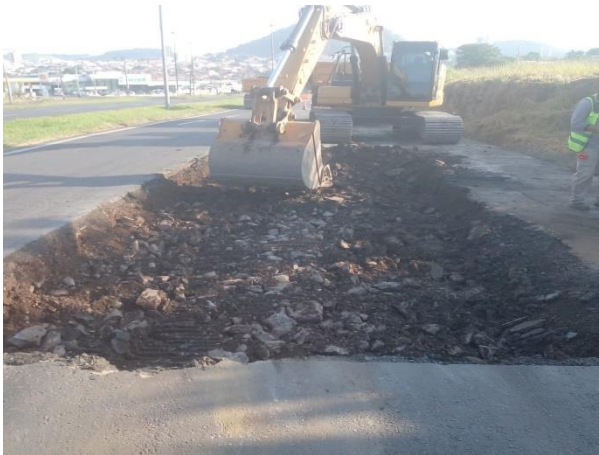
BR 153 Reparo Profundo km 42 ao km 44
