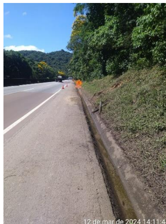
Limpeza de Drenagens – BR277
