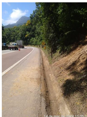
Limpeza de Drenagens – BR277
