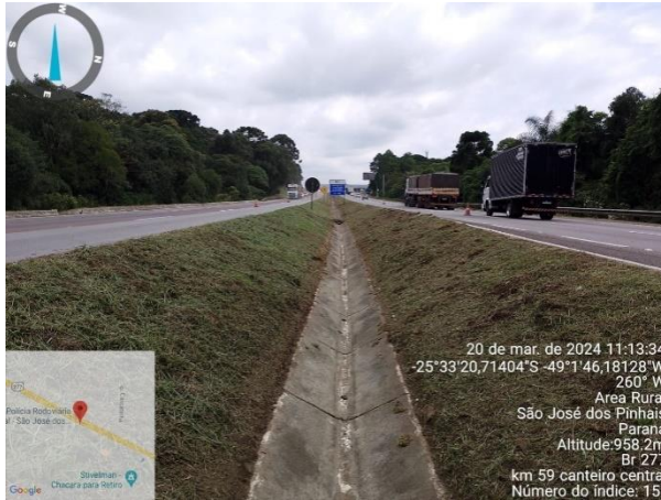
BR277 Limpeza de drenagens - São José dos Pinhais
