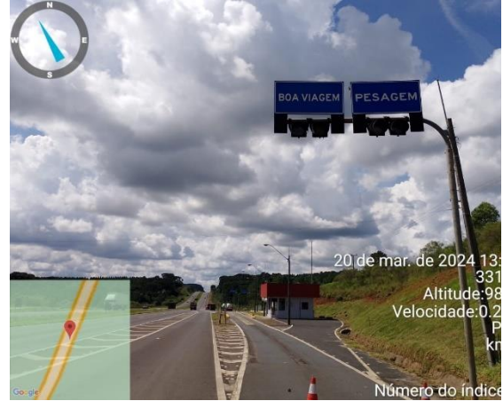
PR151 Km 264+000 ao Km 264+000
