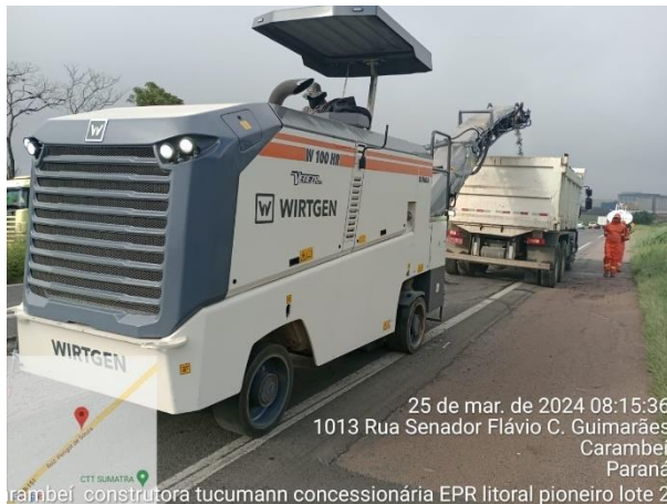
PR 151 Fresagem km 315+845 ao Km 316+280
