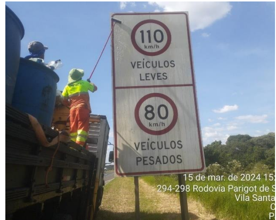
Limpeza de placas - PR151 Km 294+000 ao Km 298+000
