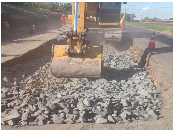
BR 153 Reparo Profundo km 42 ao km 44
