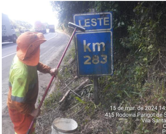
Limpeza de placas - PR151 Km 283+000 ao Km 283+000
