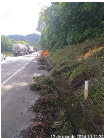
Limpeza de Drenagens – BR277
