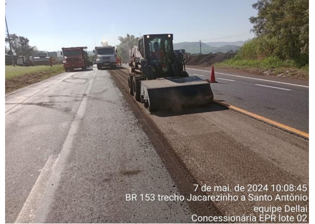
BR 153 Limpeza km 31
