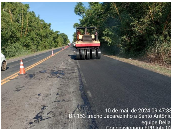
BR 153 Compactação km 18
