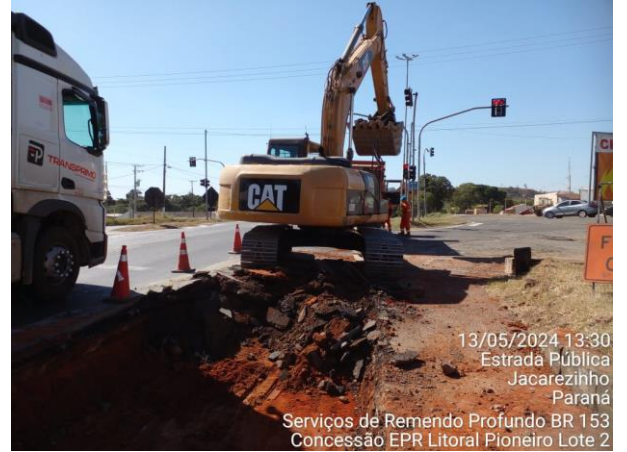
BR 153 Reparo Profundo Km 17
