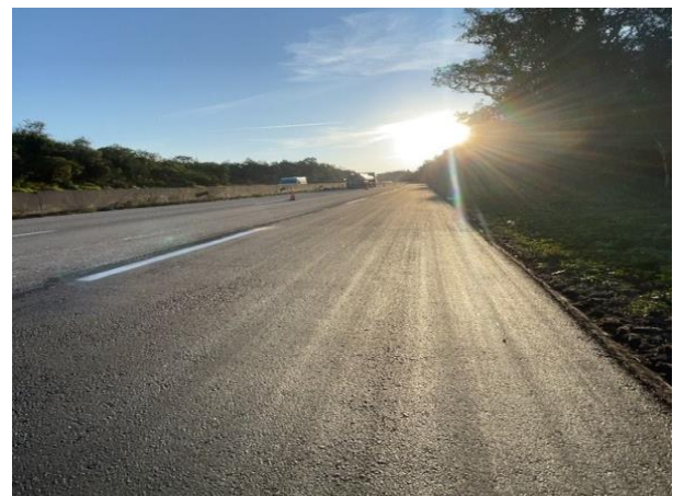
BR 277 Compactação km 44 ao 55
