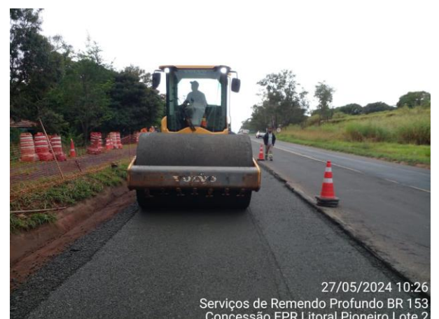
BR 153 Reparo Profundo Km 42
