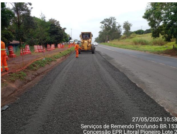
BR 153 Reparo Profundo Km 42
