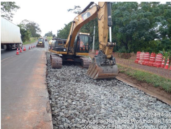
BR 153 Reparo Profundo Km 23
