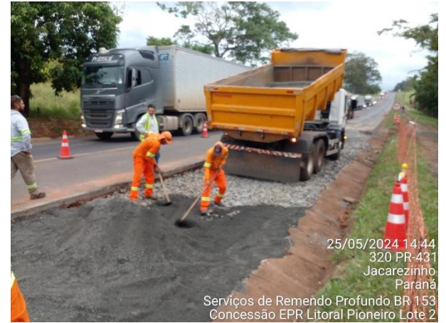
BR 153 Reparo Profundo Km 23
