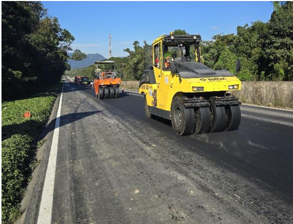
BR 277 Compactação km 44 ao 55
