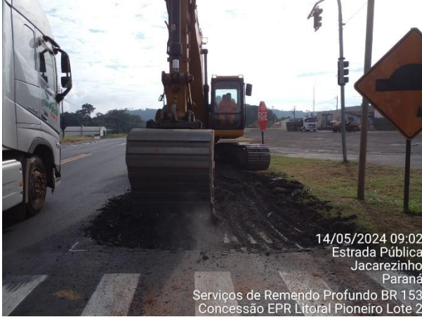
BR 153 Reparo Profundo Km 17
